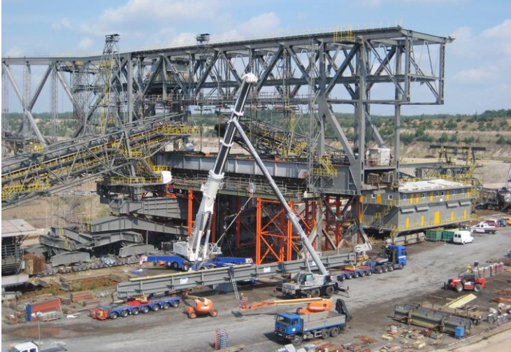
Bei XXL-Produkten werden selbst Reparaturen zum Großprojekt: Mitarbeiter der TAKRAF GmbH wechseln ein Trägerbauteil an einer Förderbrücke. (Foto: TAKRAF/Jurkschat)
